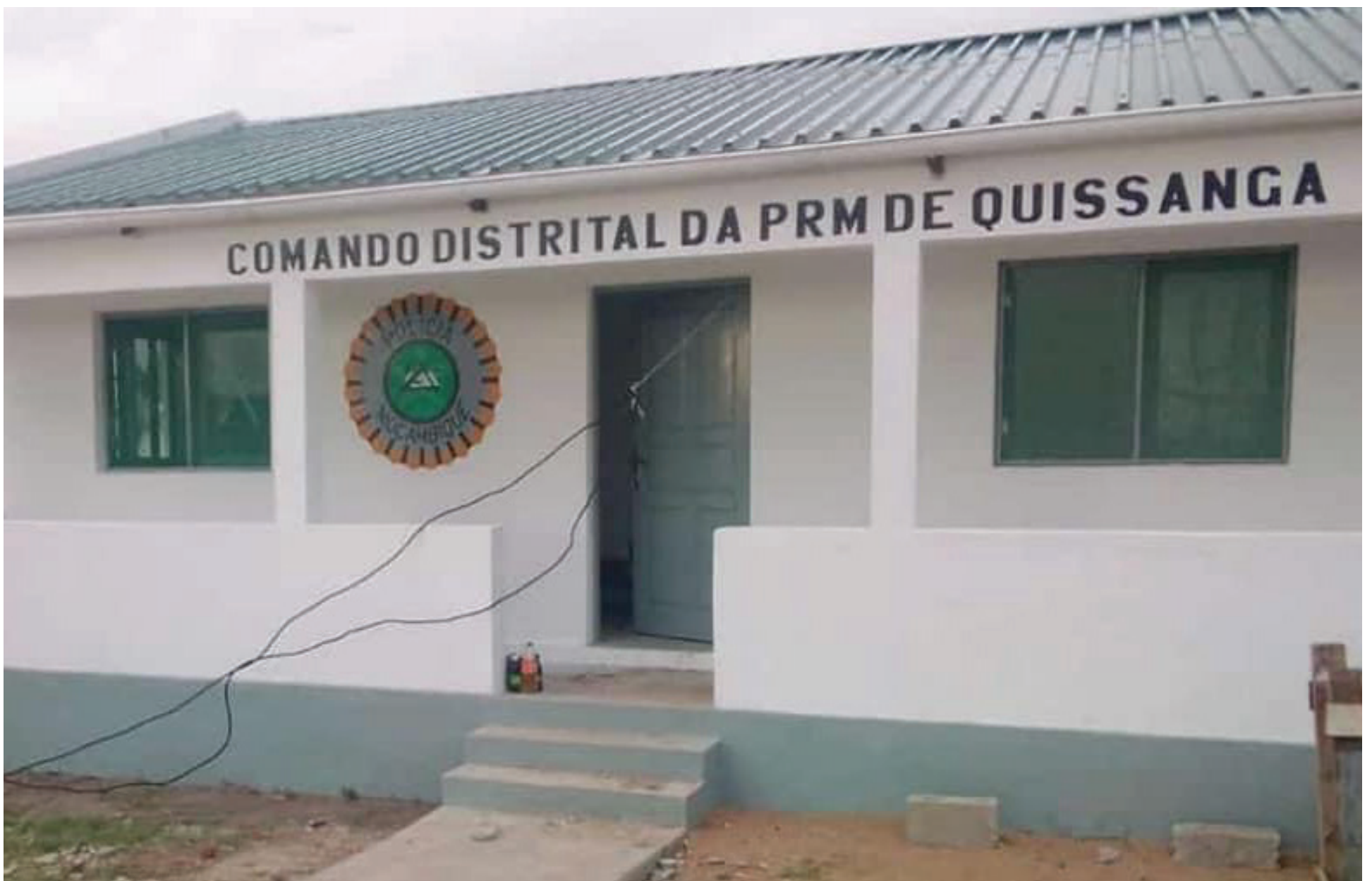
Comando distrital da PRM em Quissanga é dos pouquíssimos edifícios públicos rehabilitados
