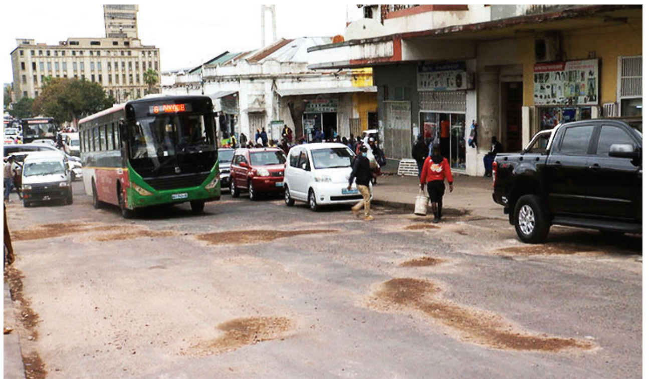
Únicas obras de Comiche consistiram no tapamento de buracos
