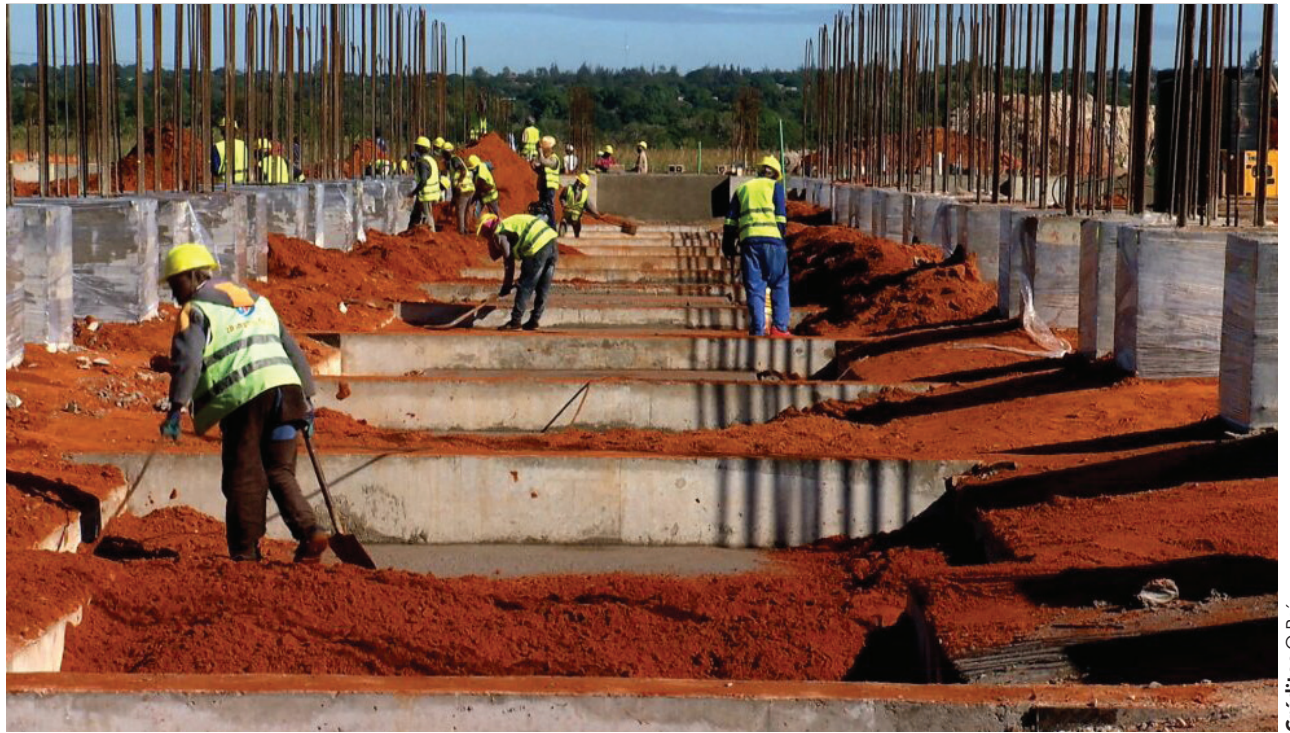
Obras de construção de portagens na Circular de Maputo
