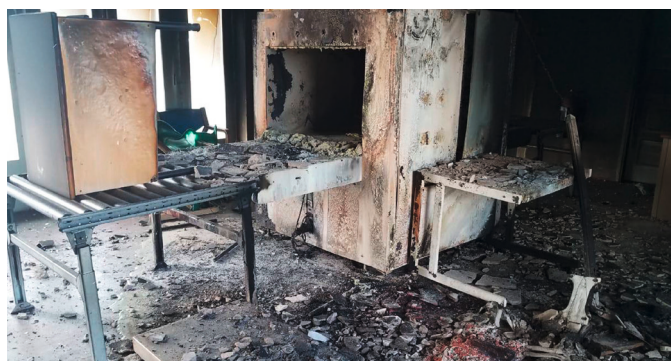
Aeródromo de Mocímboa da Praia vandalizado
