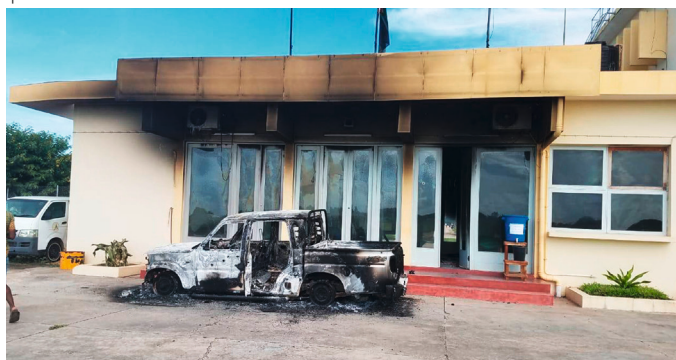
Vandalização do Aeródromo de Mocímboa da Praia
